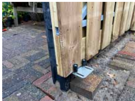
5. Ondergeleider, op de paal of op de plaat geschroefd. De schuifdeur moet tussen de 4 rolletjes geleiden.
