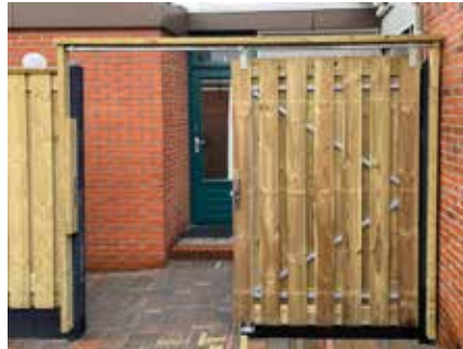
5. Ondergeleider, op de paal of op de plaat geschroefd. De schuifdeur moet tussen de 4 rolletjes geleiden.
