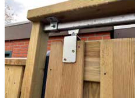
5. Ondergeleider, op de paal of op de plaat geschroefd. De schuifdeur moet tussen de 4 rolletjes geleiden.
